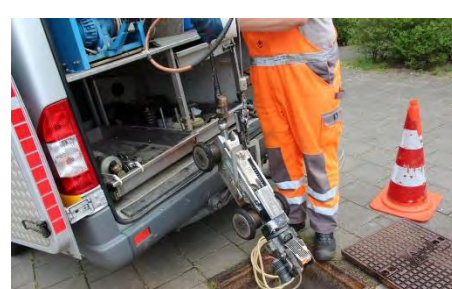
Visuele inspectie riolering voor inspecteurs
