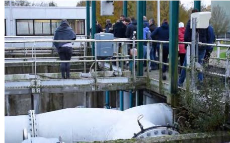
Techniek afvalwaterzuivering (TAZ)
