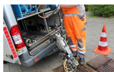
Visuele inspectie riolering voor inspecteurs
